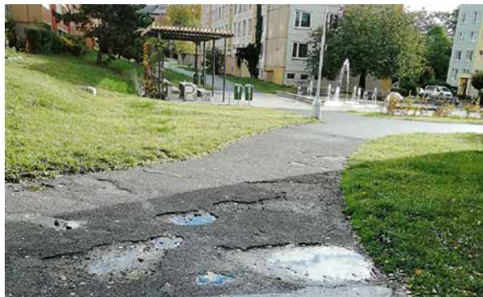
▲ V ulici Na Dolíkách směrem k Bezručově dojde k výměně 45 metrů asfaltového povrchu za zámkovou dlažbu.
